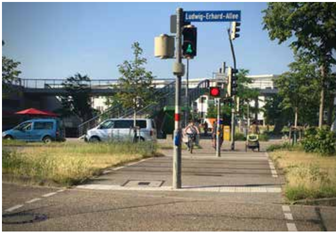
Zum Beispiel Sicherheit: Überweg Ludwig-Ehrhard-Allee – hier fehlt die Synchronisierung der Ampelschaltung und die Wegführung für Fußgänger und Radfahrer ist zu schmal.
