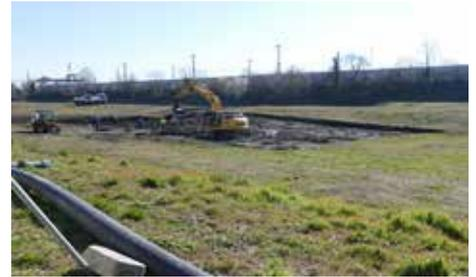
Zwischenzeitlich ist die Baustelleneinrichtung im Osten erfolgt und in der Nähe des Tivolis wurden erste Maßnahmen, wie Bodenaushub und Verlegung einer Entwässerungsleitung begonnen. (s. Bilder)
