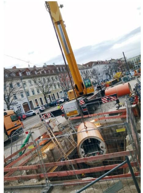
Einsatz des Bohrkopfs in der Startgrube. Foto: BST
